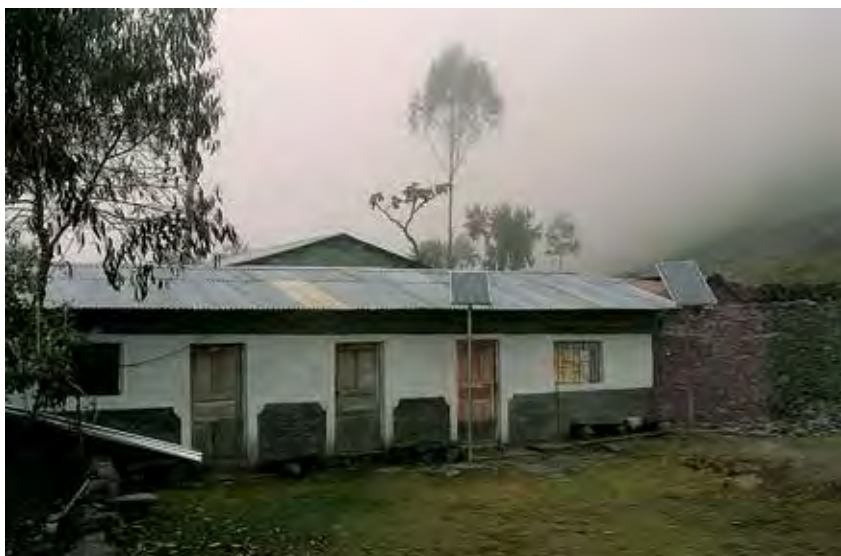
Paneles solares en la escuela de la comunidad de keara, Cordillera de Apolobamba.
